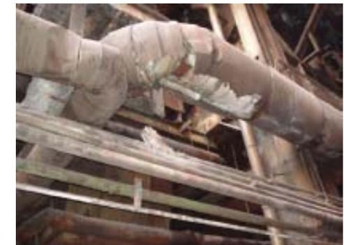
*Détail de tuyauterie isolée avec l'amiante*
