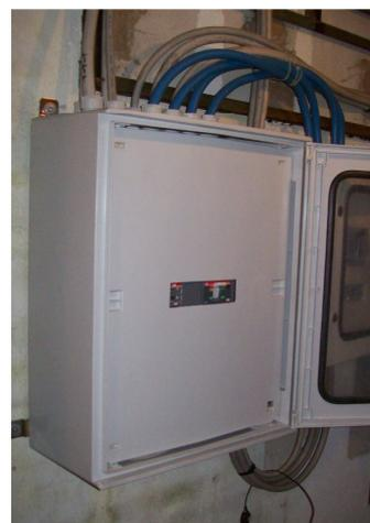
Alcune volte tale interruttore generale e/o il gruppo di consegna dell'energia elettrica si trovano all'interno dello stesso edificio con pericolo d'incendio, in locale non idoneamente compartimentato con resistenza al fuoco predefinita.
