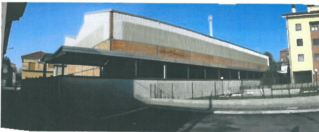
Il capannone industriale, che presenta struttura trave/pilastro in cemento armato con copertura con tegole, ha superficie circa 600 m<sup>2</sup>. Le facciate sono
