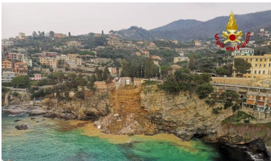
Figura 1.5 – Crollo cimitero Camogli (foto: Corpo nazionale dei Vigili del Fuoco)
