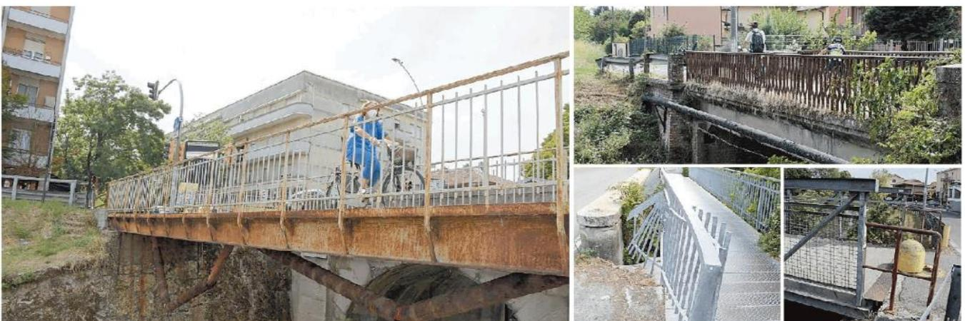
La ruggine sulla struttura del ponte pedonale sul Naviglio in via Tasso. A destra, in alto il ponte sul Naviglio di via Brichetti. Sotto a sinistra i danni alle strutture di protezione delle passerelle
