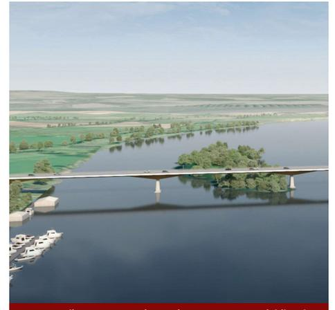
Proposta di ponte con sezione mista a spessore variabile e luce c
