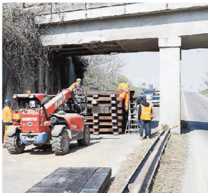
Lavori di consolidamento del ponte ferroviario a Sannazzaro
