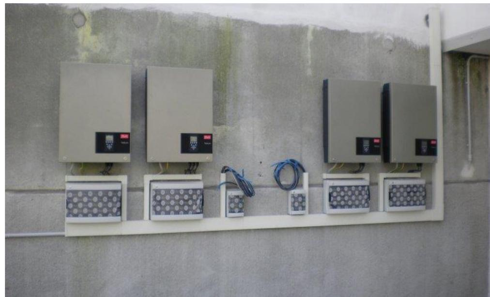
Inverter impianto fotovoltaico
