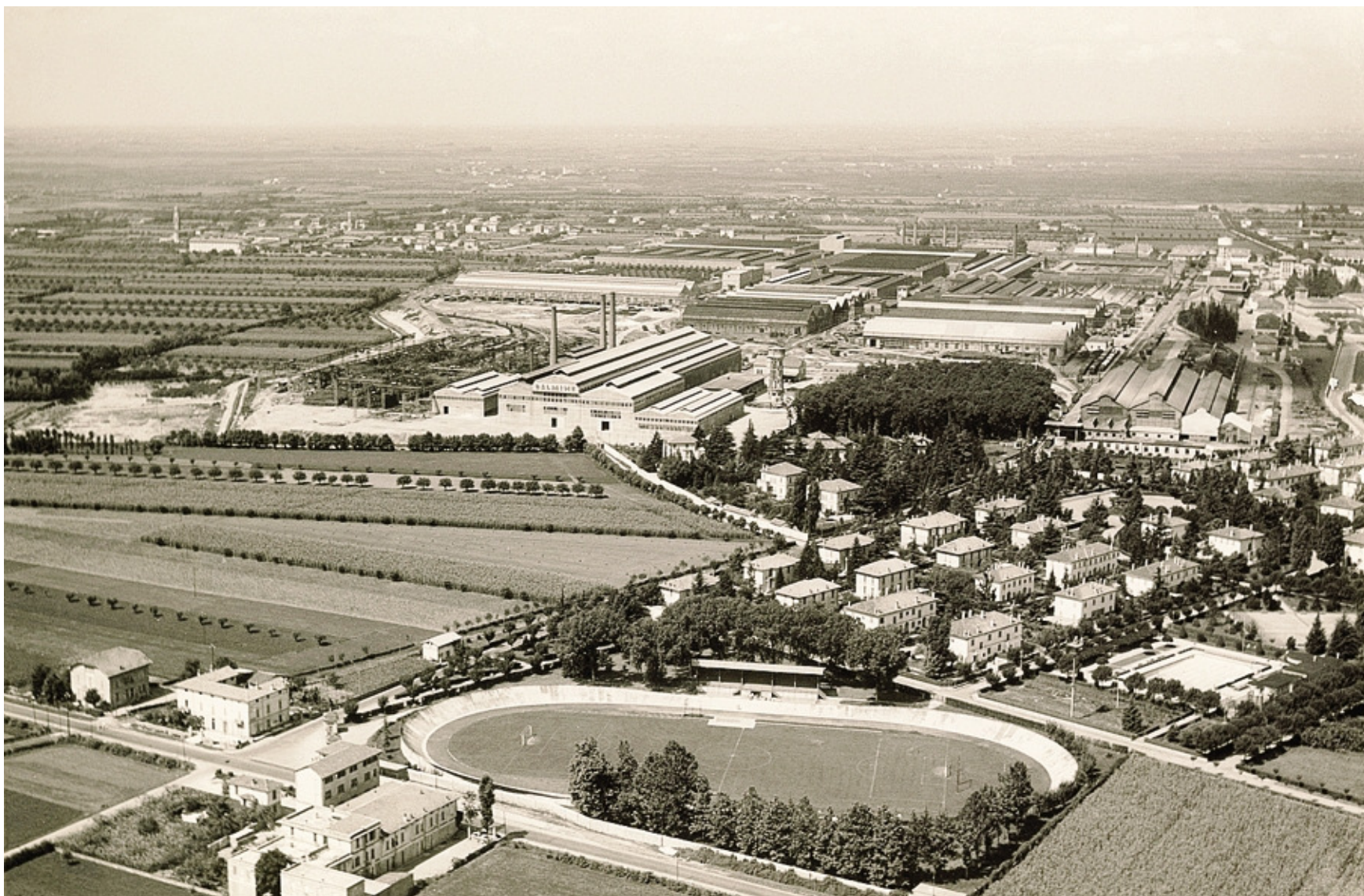
Dalmine all'inizio degli anni '50 con lo stabilimento e la «company town» FOTO STUDIO DA RE © FONDAZIONE DALMINE
