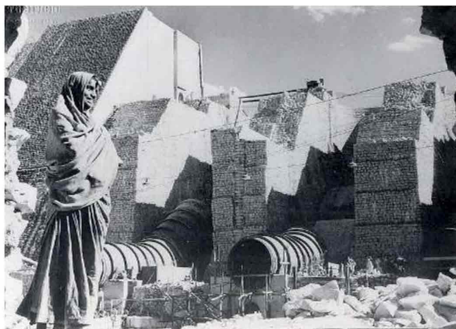
1970. Cantiere di Gandhi Sagar Power Plant
