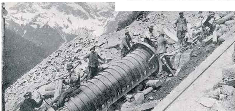
Anni '20. Yanacoto (Perù): impianto per la Lima Light Power & Tramways Company Empresas Eléctricas Asociadas
