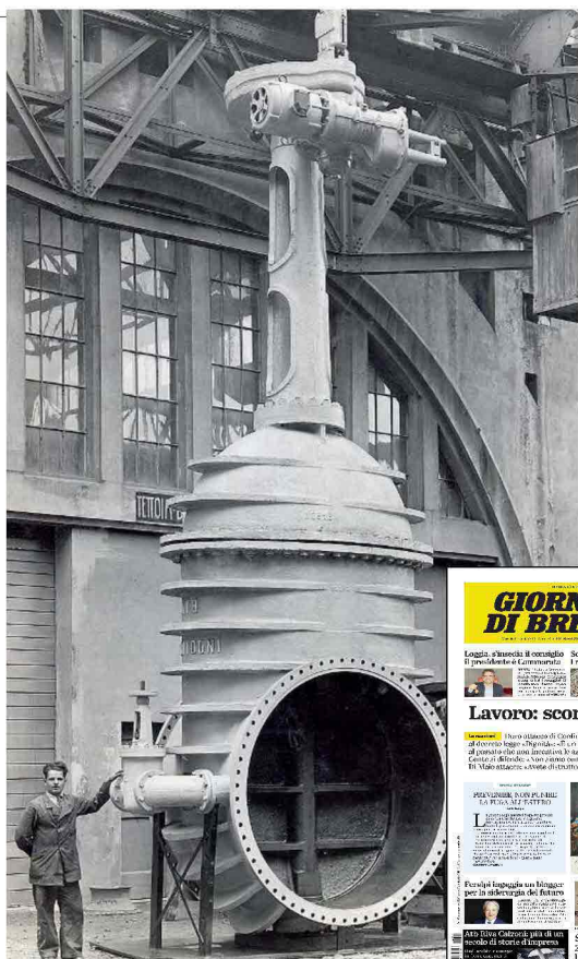
1940. Saracinesca per l'impianto della diga di Pontechianale
