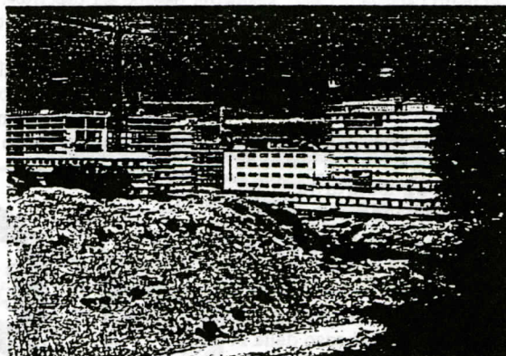
Lavori in corso nell'area della Bicocca
